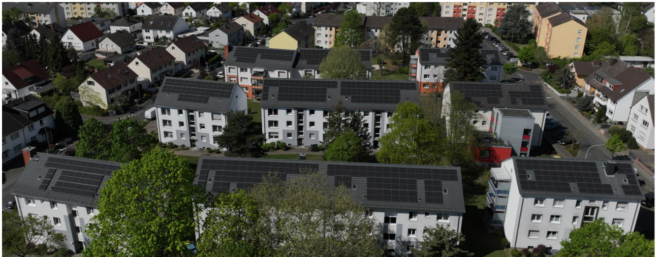
PV-Anlage Gartenstraße 53-73 / Schützenstraße 78-86
